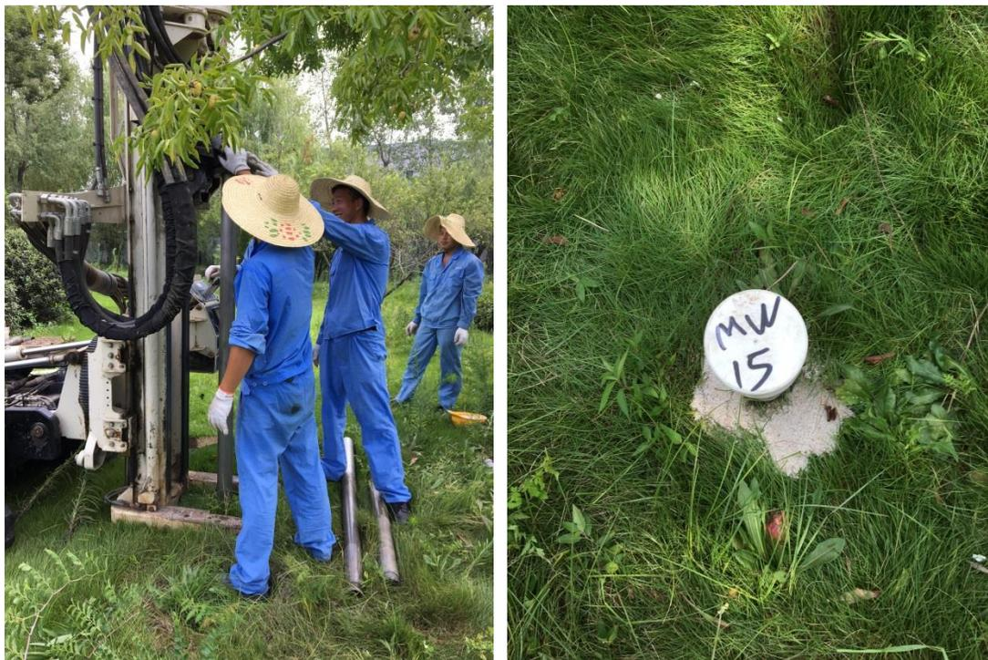
图 6.3 Geoprobe 监测井的布设
